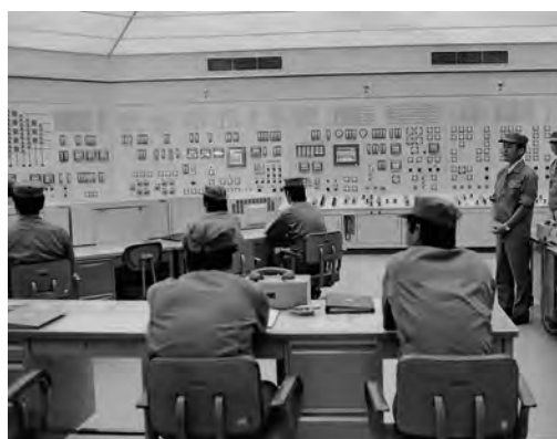
原発の総合負荷試験（コントロールルーム）
