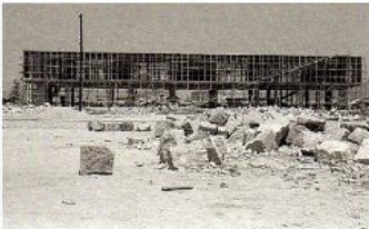
069 | 建設中の陳列館 | Museum under construction 1952年(昭和27)7月1日撮影。南側からの眺め。no.067・068とはほぼ同時期の撮影と見られるが、no.067で写っていた建設用リフトが見られず、やや進捗した状況と推測される。手前になる建設中の100m道路では、練石など多量の石材が必要とされ、その施工には、後に香川県庁舎で丹下らと協働することになる香川の石工(岡田石材工業)も加わっていた。
