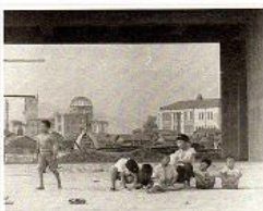
071 | 建設中の広島平和記念公園で遊ぶ子どもたち | Children playing at the Peace Memorial Park still under construction 1952年(昭和27)撮影。慰霊碑に現場打ちされたコンクリートの養生が見られ、また陳列館の丸太足場が外されていることから、no.069・070よりも後の時期、7月中旬から8月6日の竣工までに撮影されたと考えられる。各所に金網が張られているが、未整備で砂地のままの敷地は、子どもたちの格好の遊び場となったようである。
