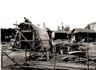
070 | 建設中の慰霊碑 | Memorial under construction 1952年(昭和27)5月30日撮影。木材(杉板か)を組み合わせ、コンクリートを流し込むための型枠が作られている。
