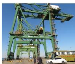
ヤードクレーン
