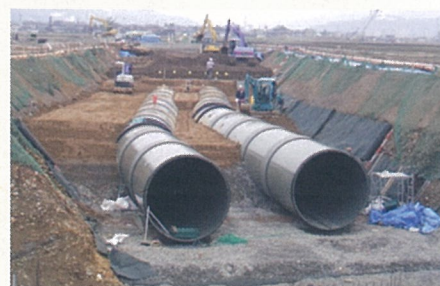
国営事業によりパイプライン化される用水路
