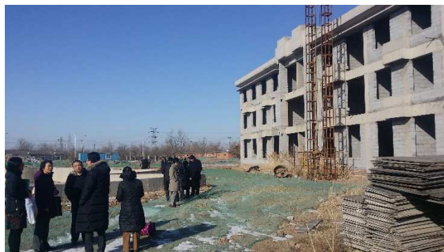
建設中の 50 億円かけた老人介護センター
