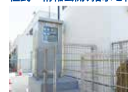
排水ポンプ場
