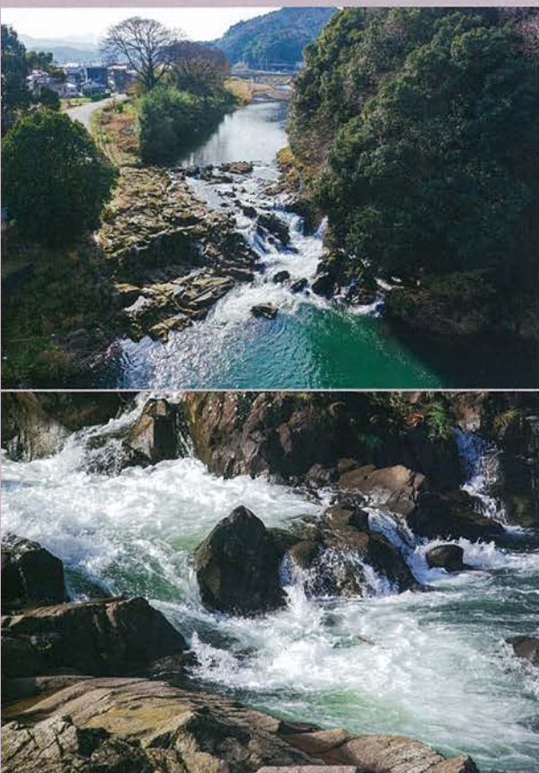
上／八雲町日吉の切り通し。開削以前は、剣山から続く稜線が川をせき止めて氾濫を招いた。削られた断面は高さ20mを超えるという。下／今も鑿の痕が残る手掘りの川床。
