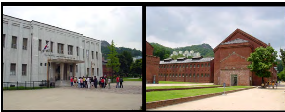
正門内部正面にある保安課庁舎（内部構造は当時のまま）
