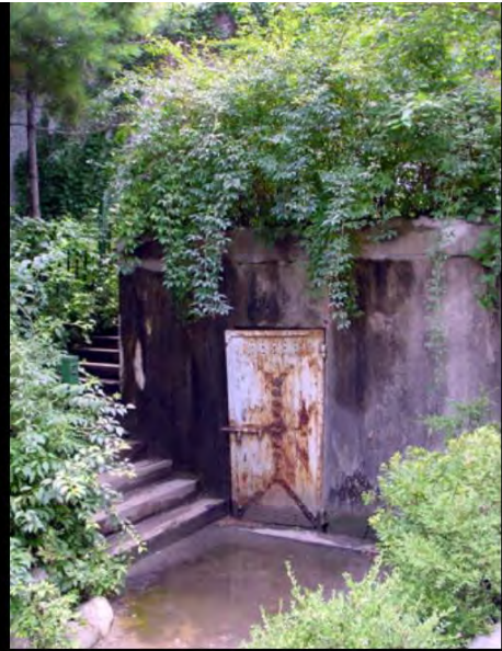
隔離病舎の死者を運んだ地下通路入り口 (階段は監視塔に続く)
