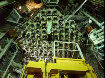
原子炉圧力容器底部のコントロールメカニズム
